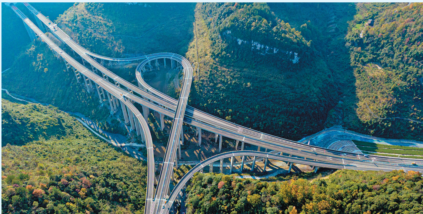
路桥公司承建的渝湘复线高速公路项目(彭著陈摄)
