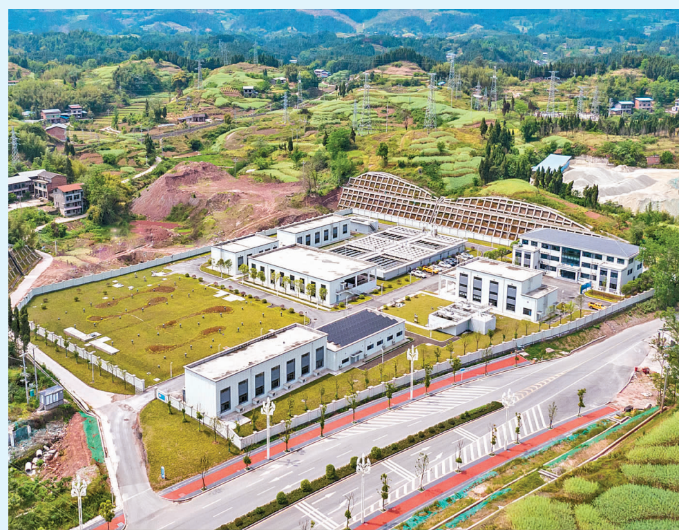
路桥公司承建的达州生态智慧城项目麻柳工业水厂(齐剑摄)
