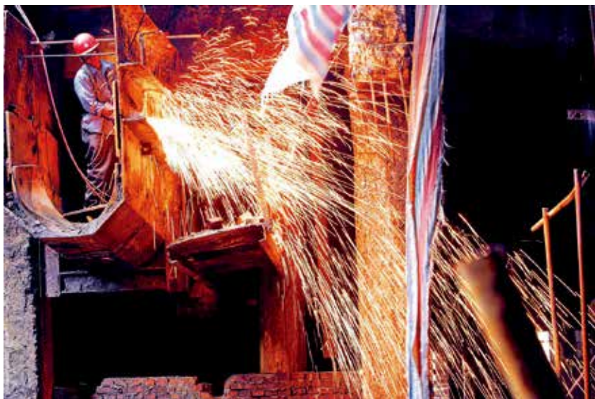
邯钢高炉旧高炉拆除
