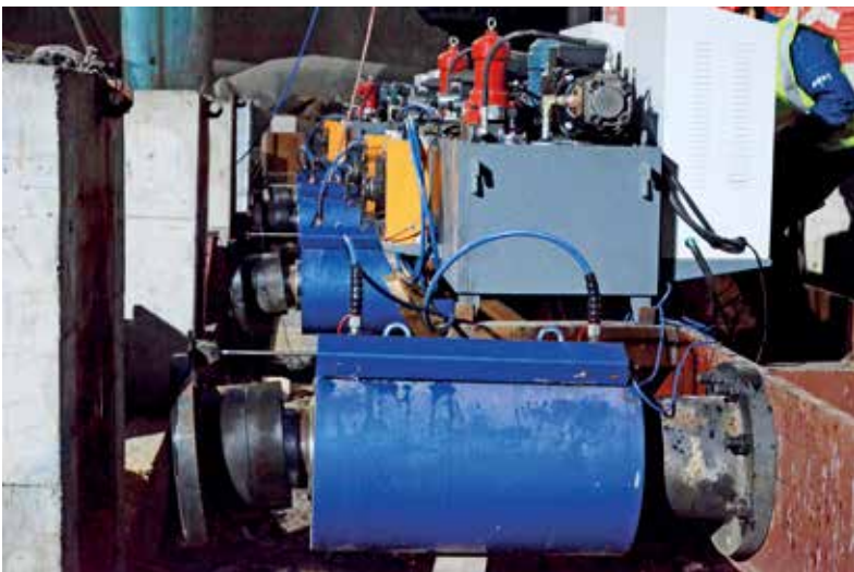
四缸八泵同步推移控制技术（液压缸）
