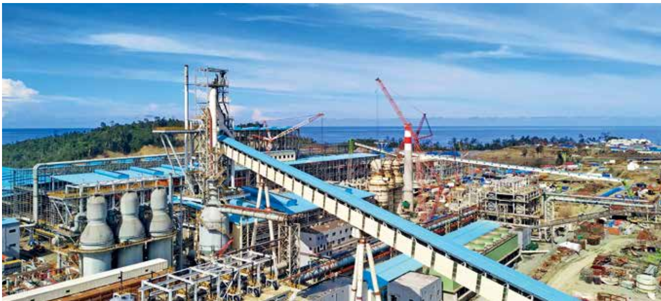
印尼德信钢铁厂1号高炉
