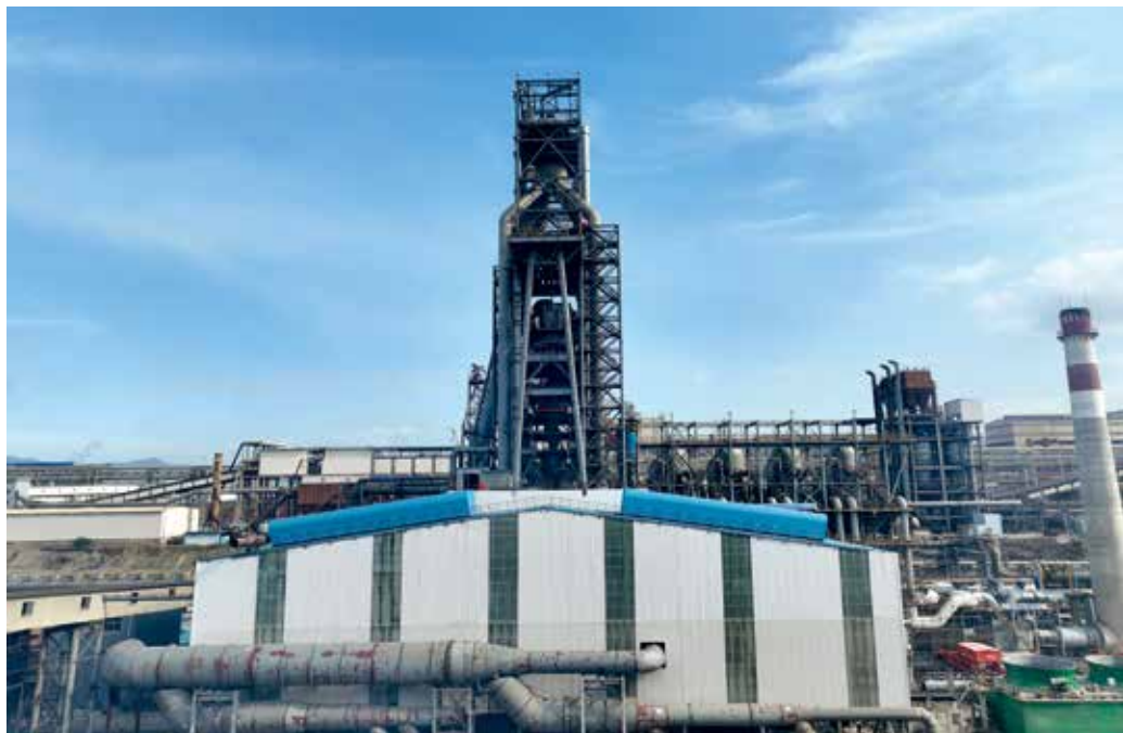
印尼德信钢铁厂3号高炉
