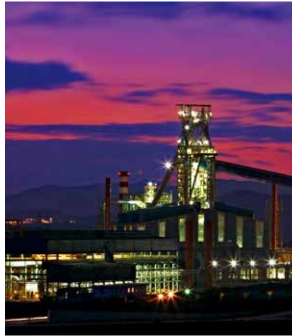
昆钢6号高炉夜景
