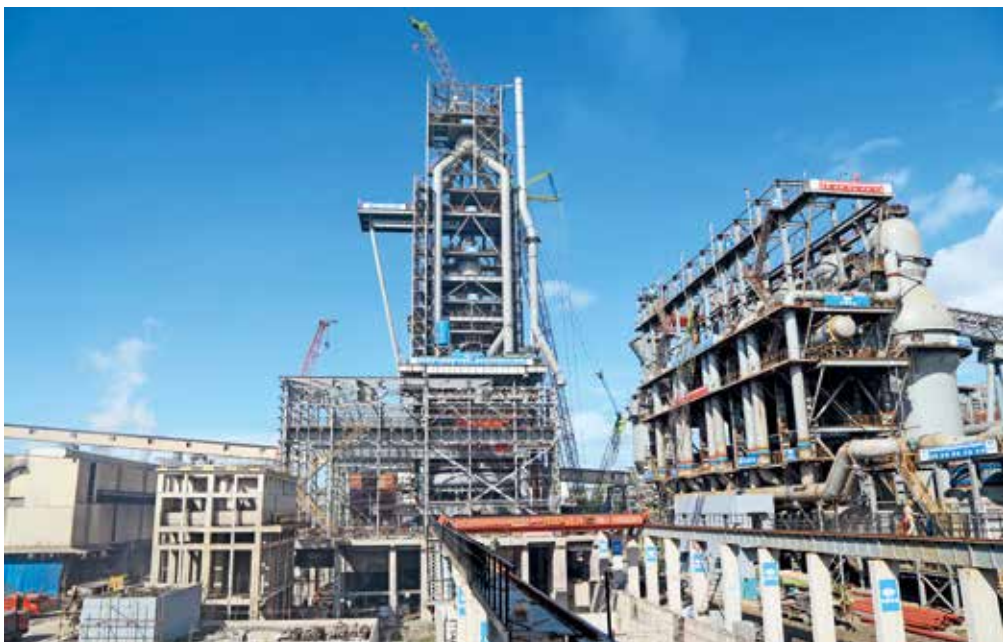
建设中的印尼德信钢铁厂3号高炉
