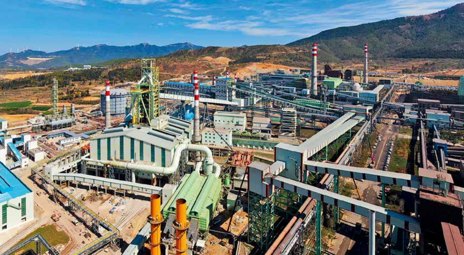
昆钢环保搬迁改造高炉
