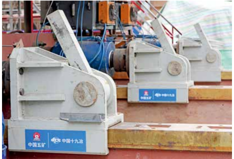
四缸八泵同步推移控制技术（液压缸）
