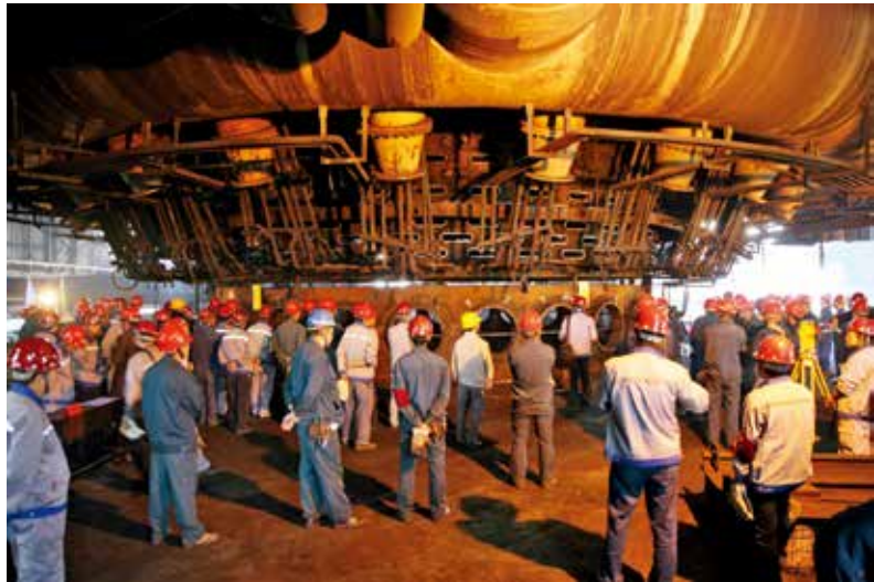
昆钢 6 号高炉炉壳合拢
