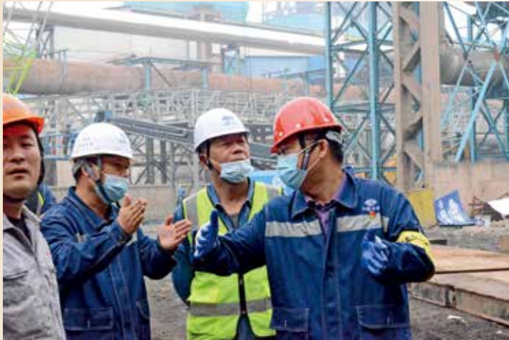
唐洪志在南钢项目现场 讲解下降管拆除方案
