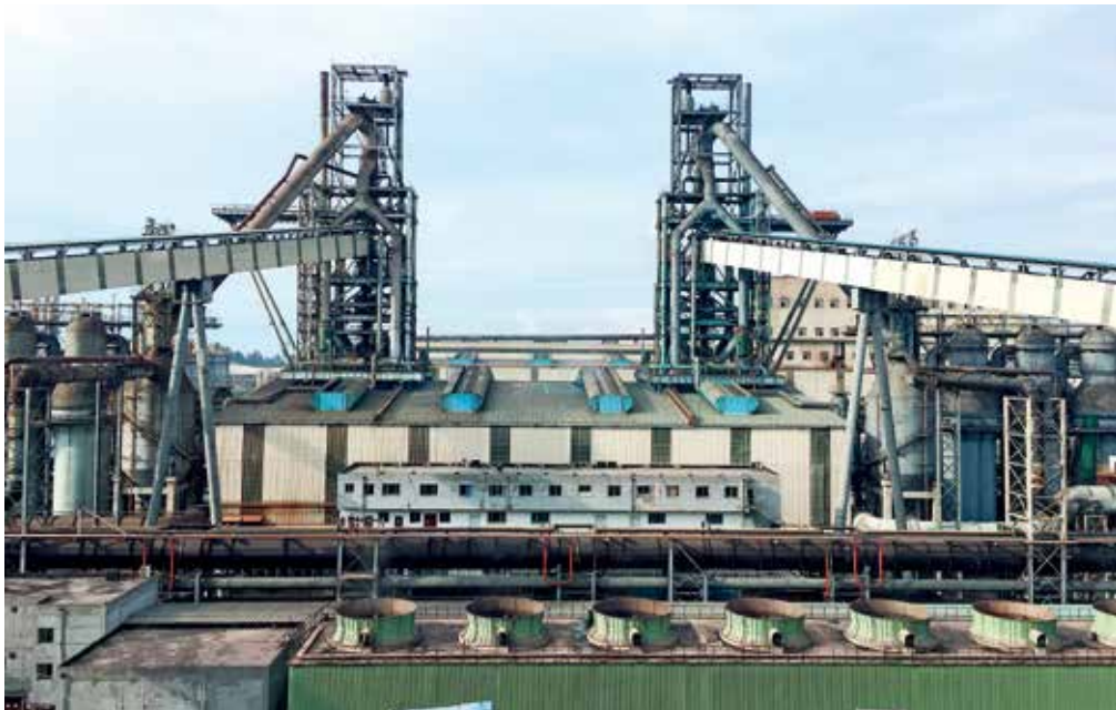
印尼德信钢铁厂1号2号高炉
