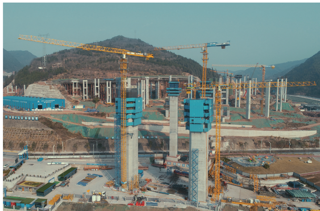
● 江龙高速项目复兴长江大桥北桥头
