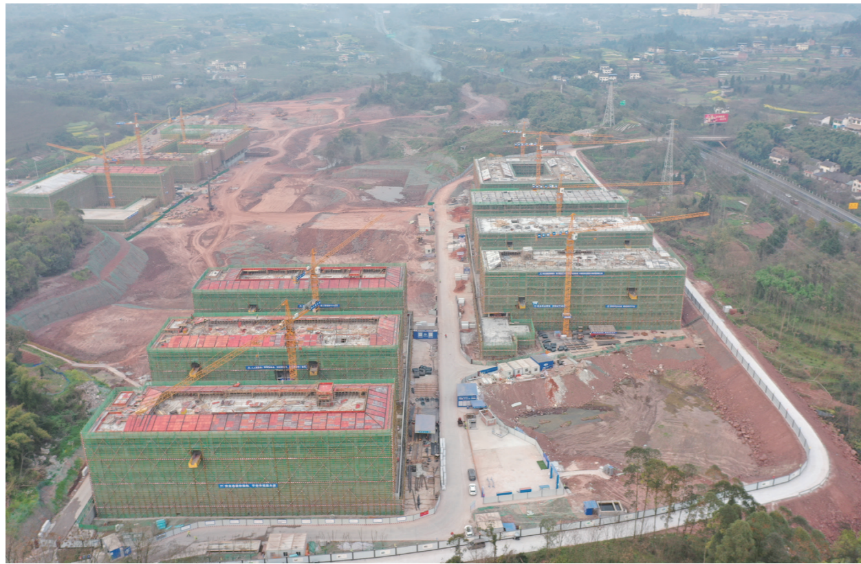
● 重庆对外经贸学院新校区项目施工现场
