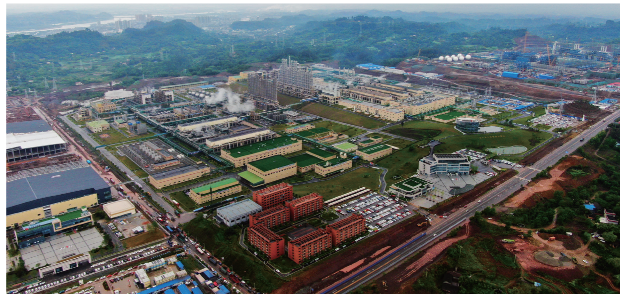
● 四川永祥新能源2.5万吨高纯多晶硅项目
