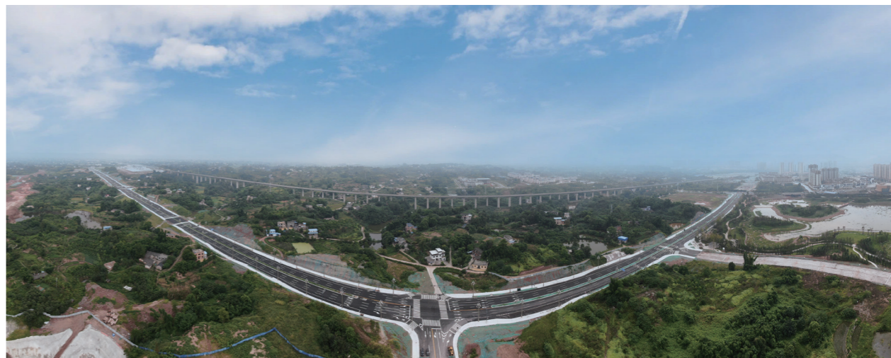
● 泸州市政基础设施PPP项目8-1-1号路、8-1-1号路延伸段、4号路CK段、8-1-2号路
