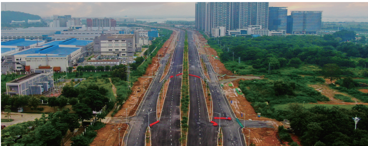
● 中山翠亨新区翠城道北地下综合管廊及同步建设工程
