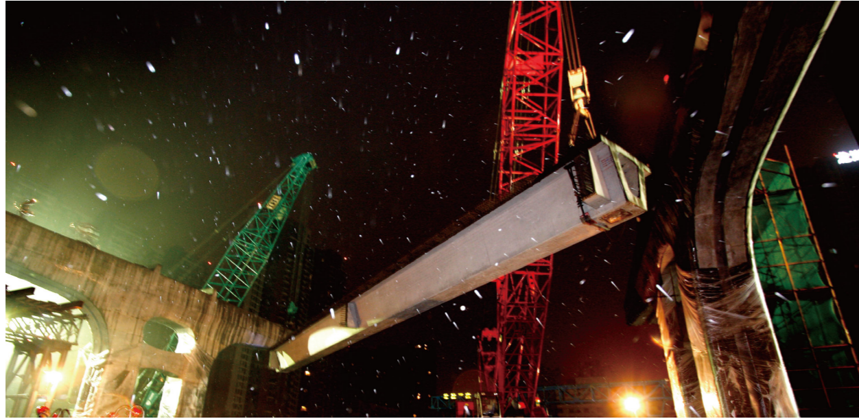
成都二环路东段改造工程进行第一片箱梁吊装
