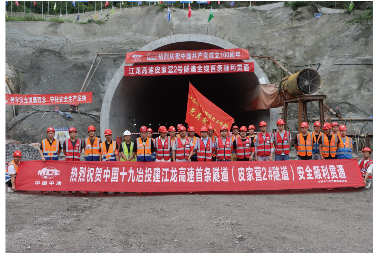
重庆江龙高速项目首条隧道(皮家营2号隧道)顺利贯通
