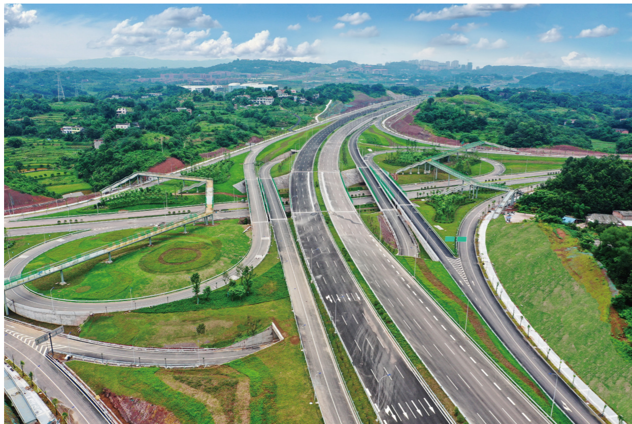
泸州二环路(纳溪段)工程
