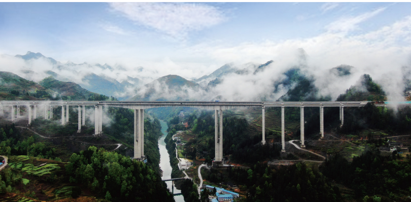
贵州遵绥高速公路芙蓉江特大桥工程
