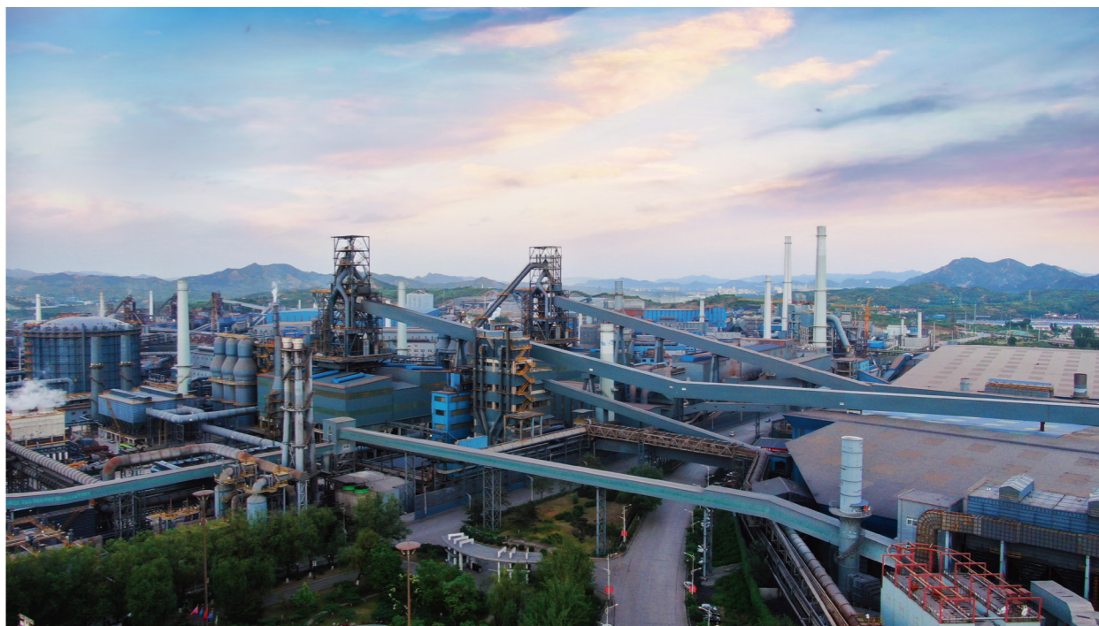
津西钢铁厂1号2号高炉工程
