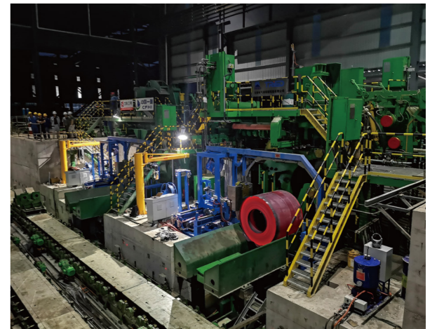
工建公司重庆攀华项目提前完成热负荷试车
