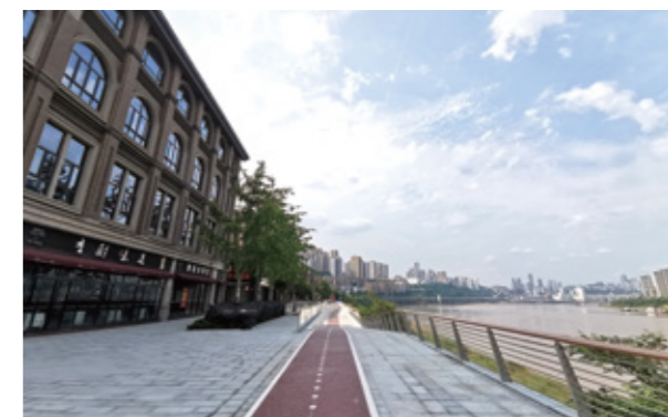
● 九龙滩项目升伟商业外街改造完工
