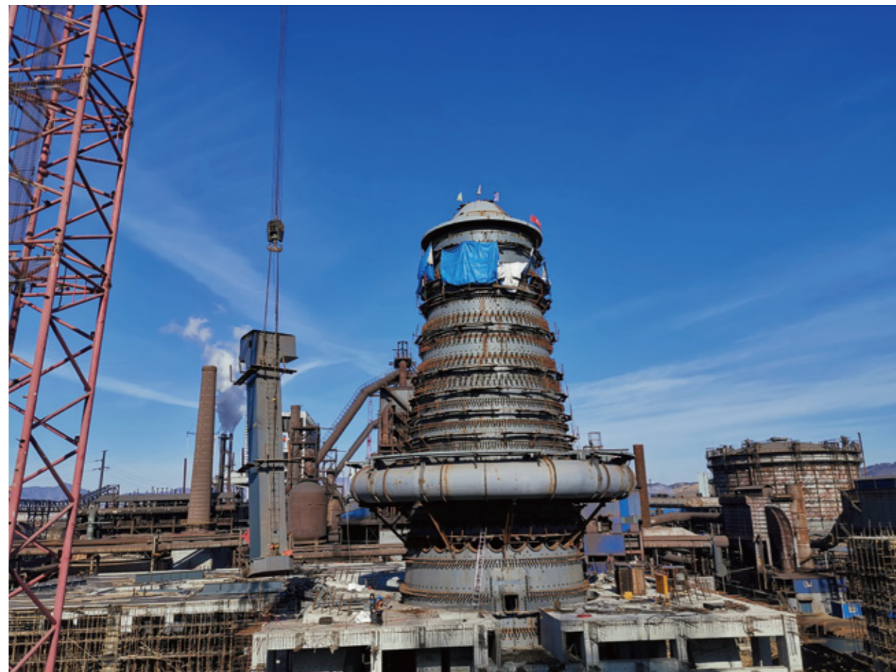
武汉公司津西钢铁项目2号高炉
