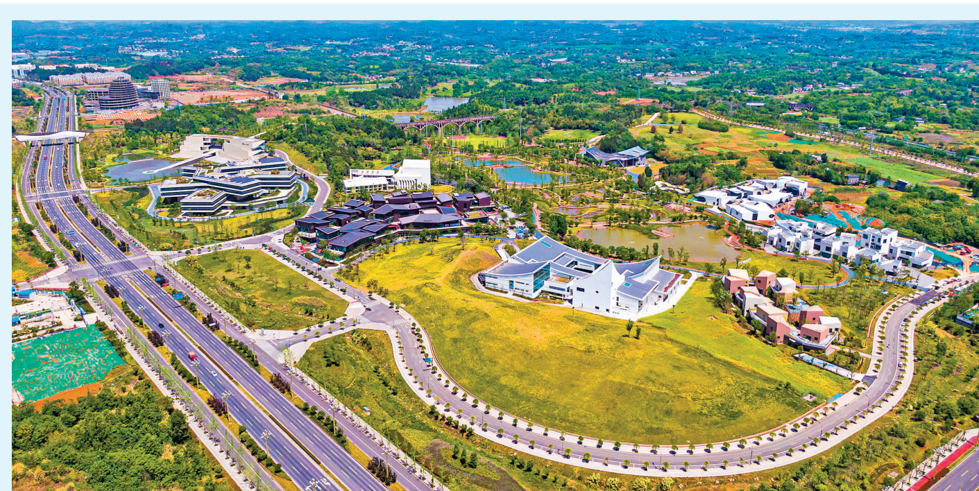
中国十九冶承建的凯州新城城乡一体化建设项目
