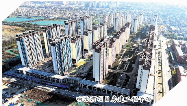
响坎河项目房建工程子项
