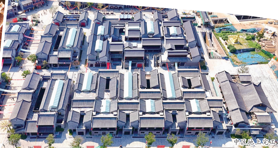
中區地上完工
