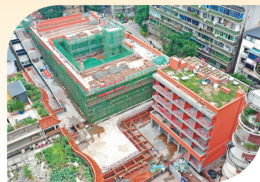
▼ 双龙片区老旧小区改造现场
