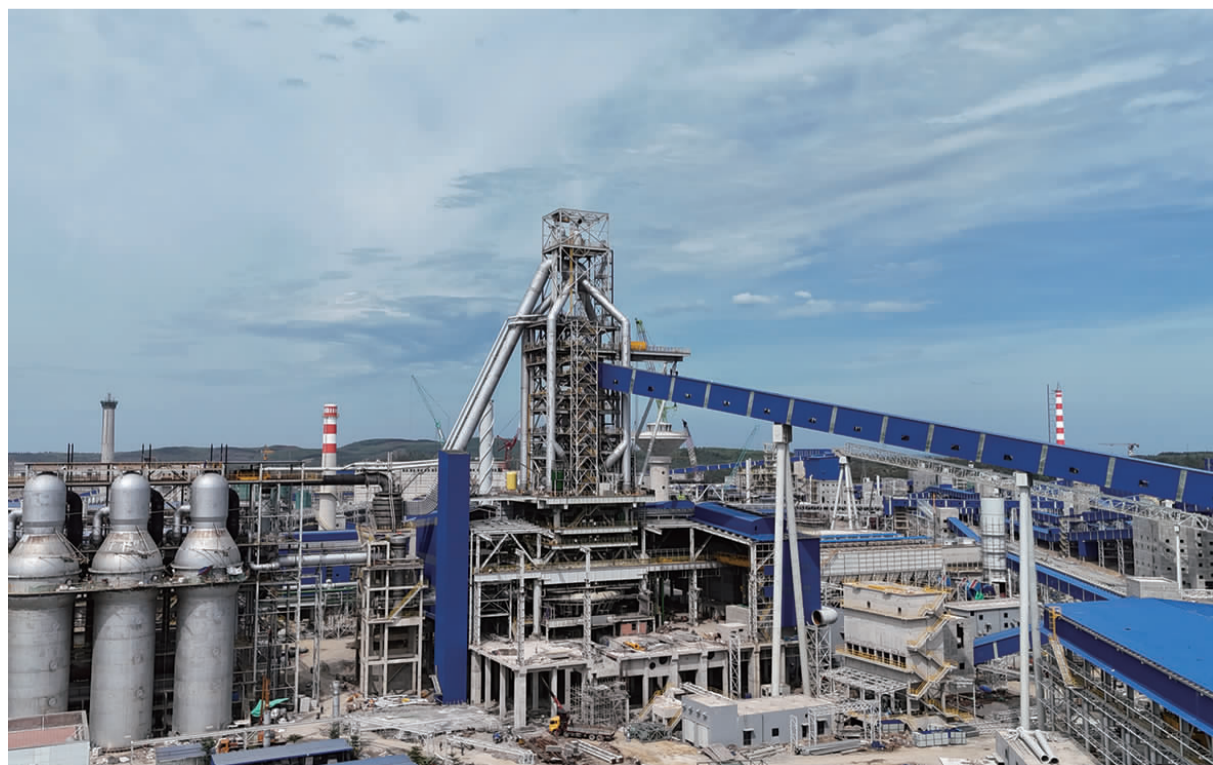
11月15日,工业工程公司承建的越南和发榕桔钢铁股份有限公司2炼铁2x2500立方米高炉炼铁总承包工程1号高炉成功点火烘炉。(黄兴彬 摄)
