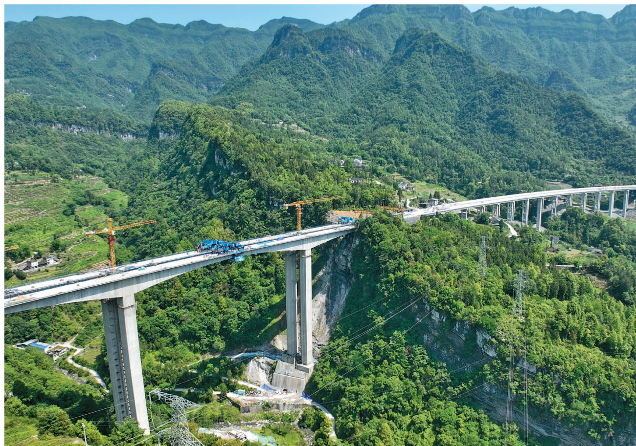
5月24日，市政交通公司承建的渝湘复线高速公路项目石桥特大桥右幅顺利合龙。（刘昭莹 摄）
