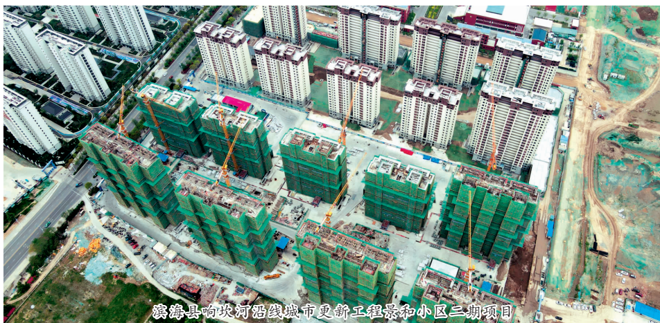
滨海县响坎河沿线城市更新工程景和小区二期项目
