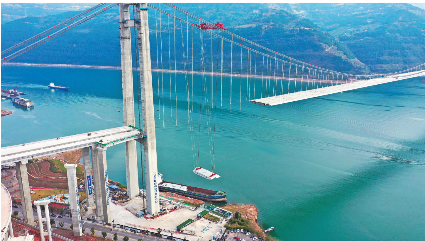
3月4日,重庆公司承建的江龙高速项目复兴长江大桥钢箱梁架梁成功落架,顺利完成架梁任务。(通讯员 刘俊辰 摄)
