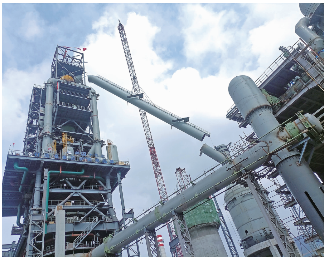
2月29日,冶金公司承建的达钢搬迁升级改造1号高炉下降管顺利吊装,标志着1号高炉结构工程进入收尾阶段。(通讯员 张恒 摄)
