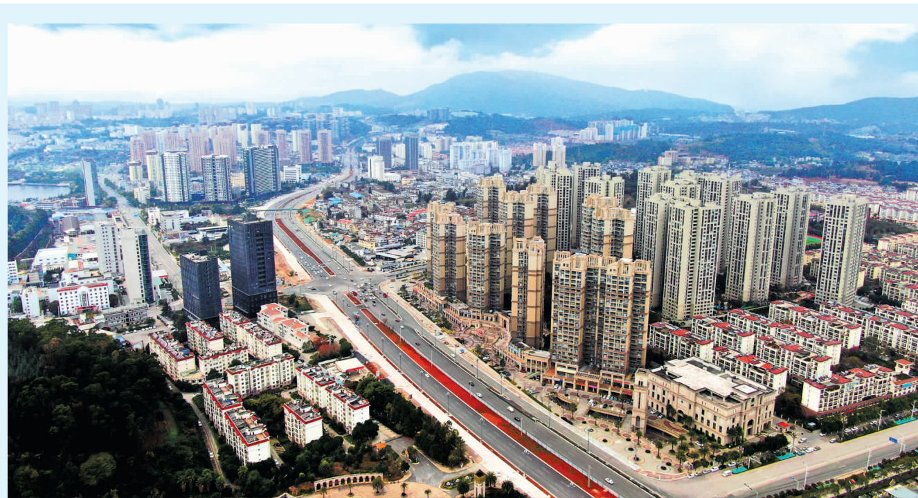
中国十九冶承建的云南安宁石安公路项目
