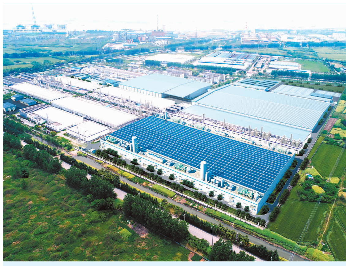
9月27日,工建公司承建的晶澳(扬州)太阳能科技有限公司年产6GW高性能太阳能电池片项目主体结构顺利通过验收。
