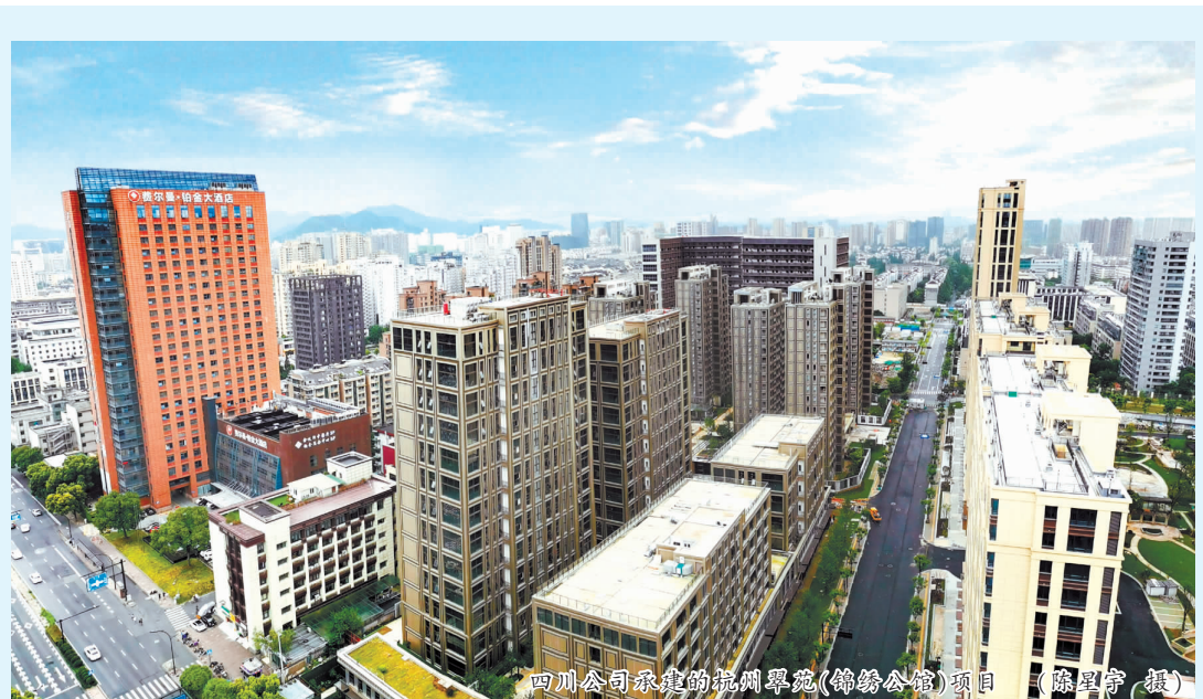
该项目位于杭州西湖区,东至教工路,西至花园北路,南至今日嘉园、保亭路,北至翠苑单元西溪商务区地区FG04-R21/C2-02地块,共有9栋建筑,包括4栋17F住宅、1栋15F住宅、2栋11F/13F酒店式公寓、2栋GF/8F商业楼,总用地面积约19914平方米,总建筑面积为84815.86平方米。建筑最大跨度8.7米,高度53.9米。
